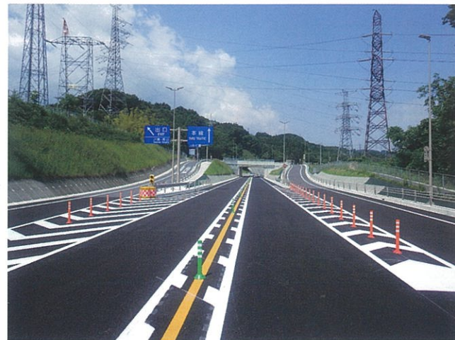
群馬県 国道 353号 車線分離・合流注意
