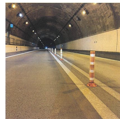
釜石自動車道 中央分離帯
