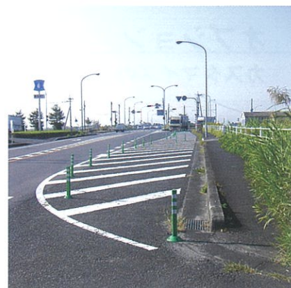
宮崎県 国道 10号 路肩の駐車禁止
