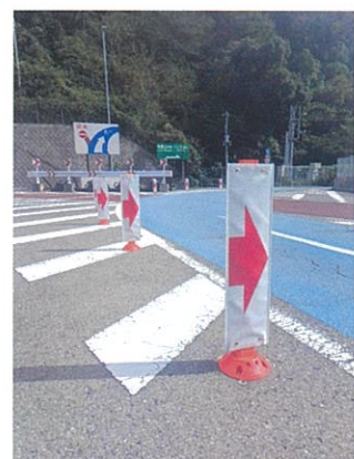
和歌山県 国道 26号 逆走防止
