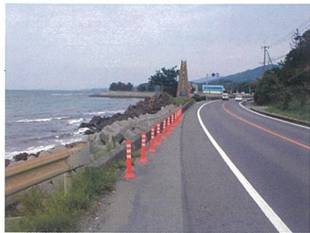
熊本県天草市 転落防止（防波堤）
