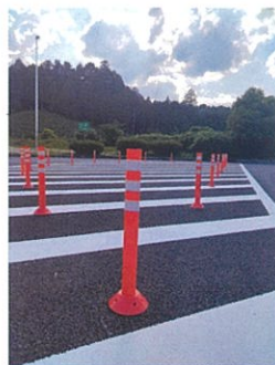
滋賀県 甲南 PA 駐車区画外への駐車禁止
