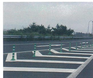
三陸自動車道
